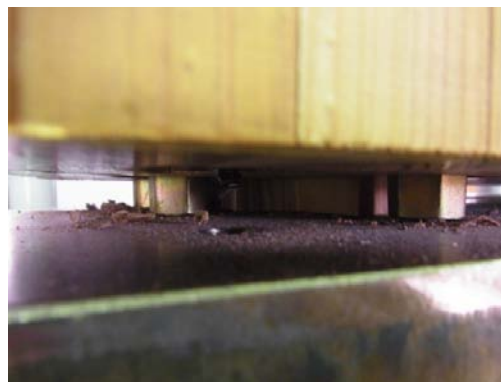
ボルトの伸び
