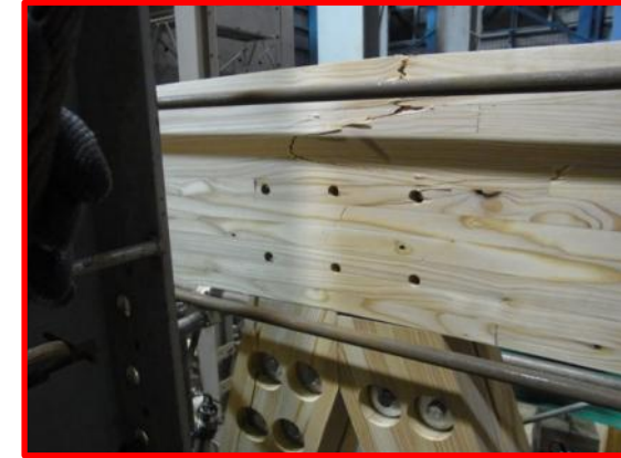
② 桁の曲げ破壊
