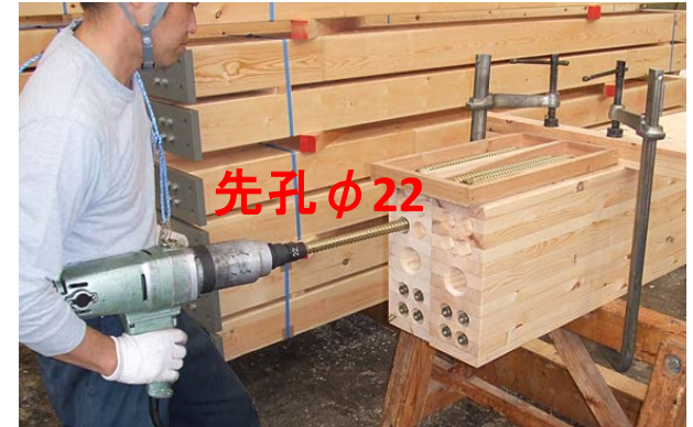
LSB打ち込み状況
