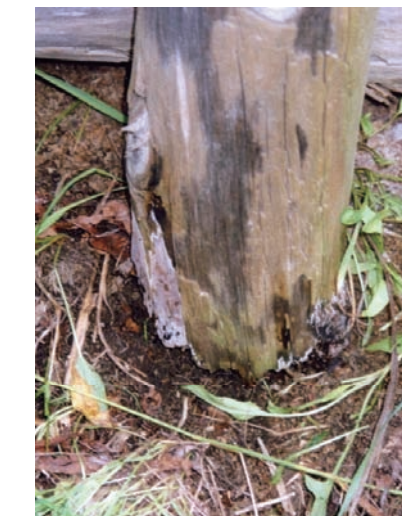
地際部分の腐朽
