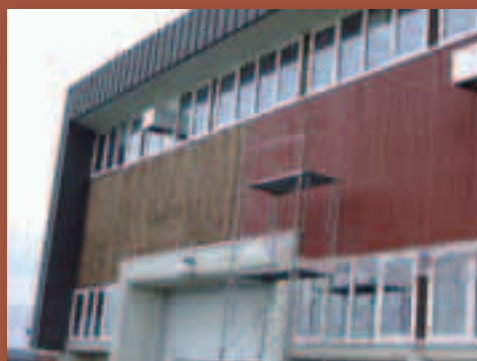
経年劣化した外壁の塗装工事
