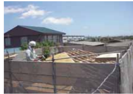
一般棟屋根下地
