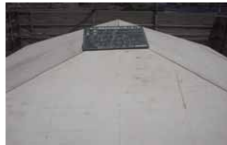
断熱棟屋根下地
