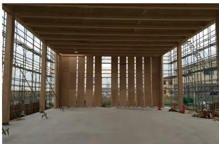
厚物構造用合板による耐力壁と水平構面の施工現場
