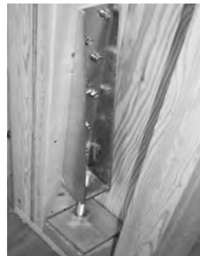
図6-5 高強度ホールダウン金物
