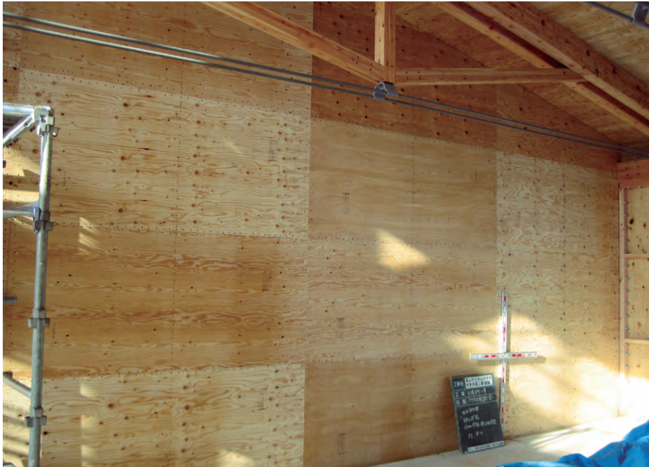
厚さ 12mm 構造用合板による耐力壁の施工現場
