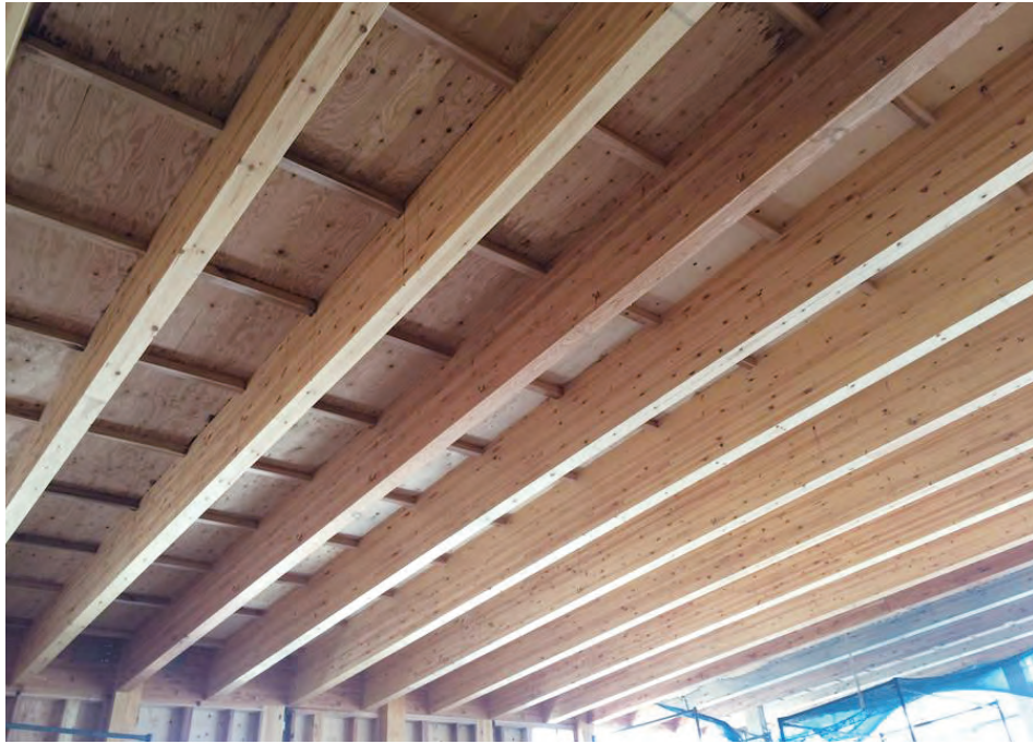
厚物構造用合板による水平構面の施工現場
