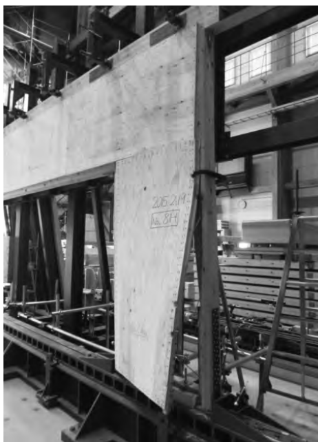
試験体8H-1 面外座屈と柱の破壊
