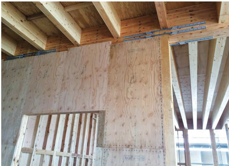
厚さ24mm構造用合板による耐力壁の施工現場 (CN75@50mm 両面張り 許容耐力47.6kN/m)
