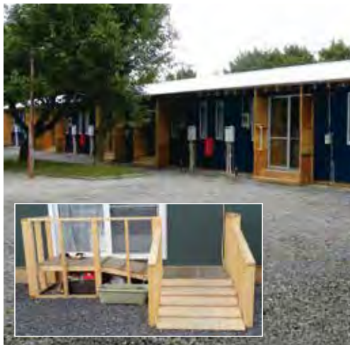
仮設住宅（岩手県山田町）
