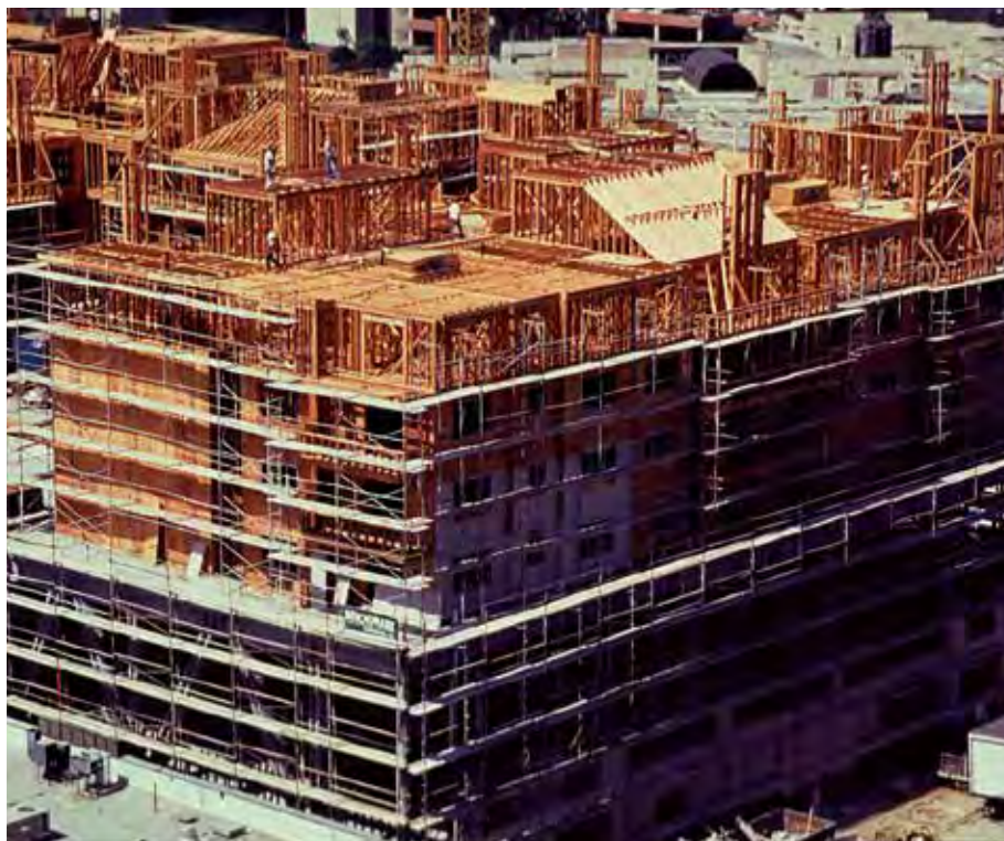
パインスクエア／パシフィックコート（カリフォルニア・ロングビーチ）： 1～4階を鉄骨造、5～8階（+ペントハウス2階）を合板の壁・床・屋根による木造とした（アメリカ WWPA 提供）
