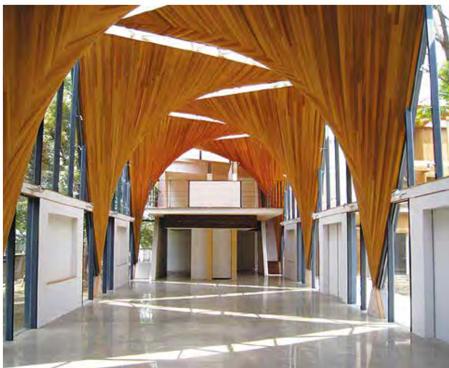
東京大学弥生講堂アネックス セイホクギャラリー：構造用合板によるシェル構造（河野泰治アトリエ 提供）
