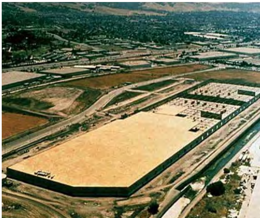
巨大倉庫：RC耐力壁と合板ダイアフラムで構成されている、スパン100m（アメリカ WWPA 提供）
