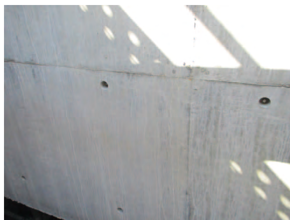
写真4．梁コンクリート面（国産材型枠）
