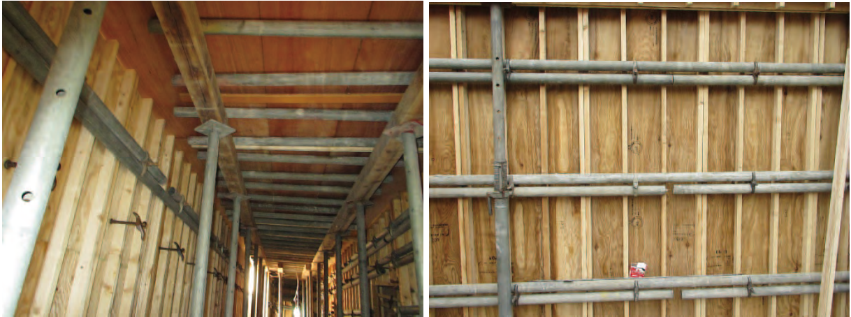
写真 4. コンクリート型枠用合板の打設状況(左:床スラブ、右:壁)
