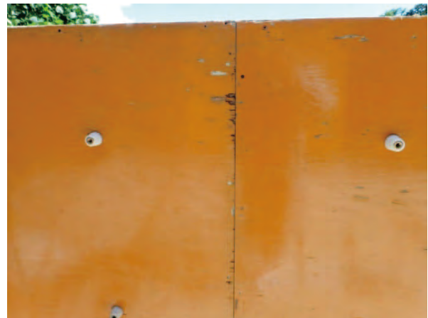
写真5．型枠継目の状況（転用2回目） 型枠の目違いもなく施工性は良
