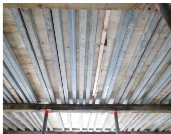
写真 3. 国産材型枠スラブ（無塗装）
