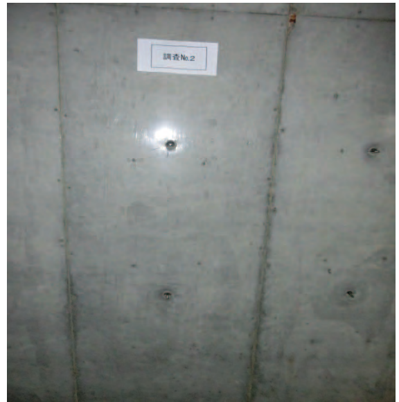
写真7．15階（12回転用）の間仕切り壁（国産材型枠）のコンクリート表面。たわみ・はらみ問題なし
