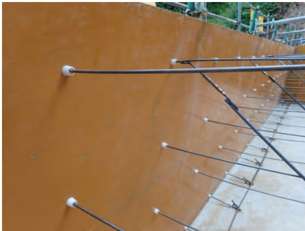
写真4．セパレータ設置状況（転用2回目）
