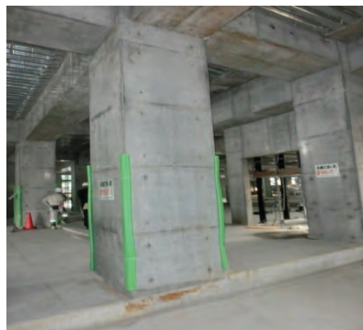
写真5．コンクリート柱面（国産材型枠） たわみ・はらみの問題なし
