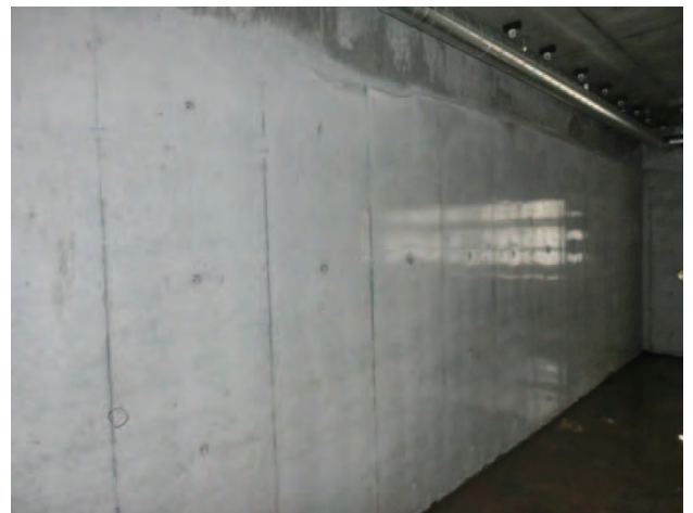
写真3．2階コンクリート壁面（国産材型枠） （たわみ・はらみの問題なし）
