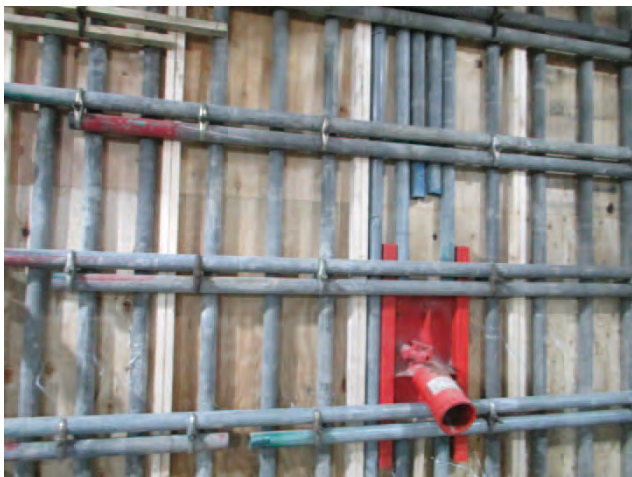
写真5. 地下1階の内壁建て込み：圧入式コンクリート打設工法（国産材型枠 2 × 6 サイズの縦使い、単管 3 本）
