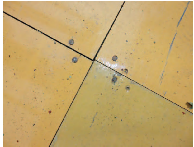
写真2. 約1mmサイズのずれ (結果的に問題なし)
