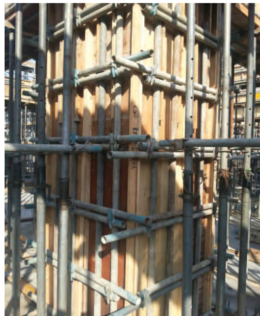
写真3．柱建て込み（国産材合板型枠 3×6サイズの縦使い）
