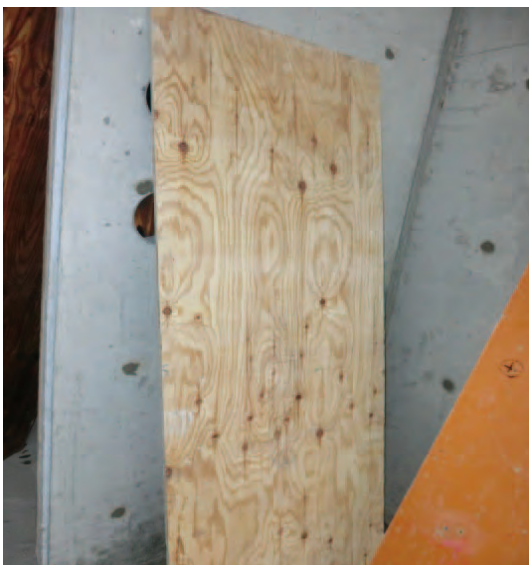
写真10．12回転用した国産材型枠の裏（間仕切り壁用）
