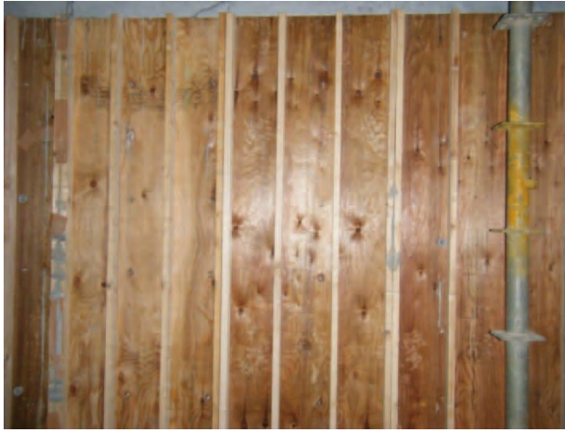
写真3. 地下1階外周壁建て込み（国産材型枠 2 × 6 サイズの縦使い、栈木 2 本）
