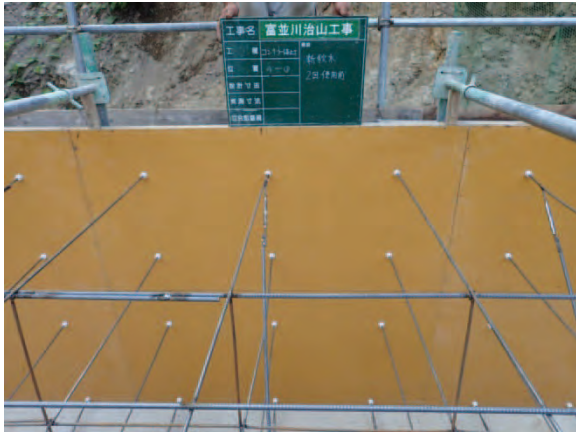
写真 8. セパレータ設置状況（転用 2 回目） 型枠の据付など収まりも良い
