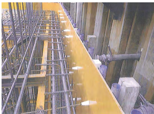
写真2. 橋台（国産材型枠）
