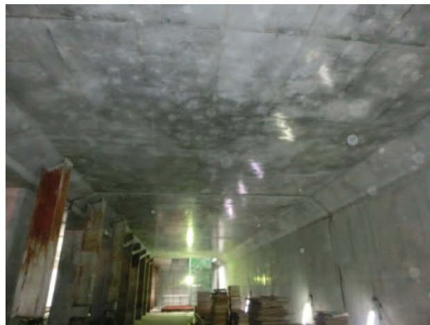
写真5. ボックスカルバートの天井部分 (国産材型枠)
