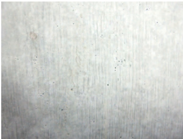
写真6．ラワン型枠のシワ
