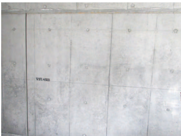
写真3. 国産材型枠使用のコンクリート表面 (たわみ・はらみの問題なし)
