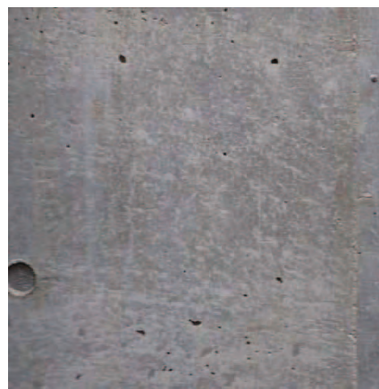
写真 11. 国産材型枠（AE） 2 回目状況
