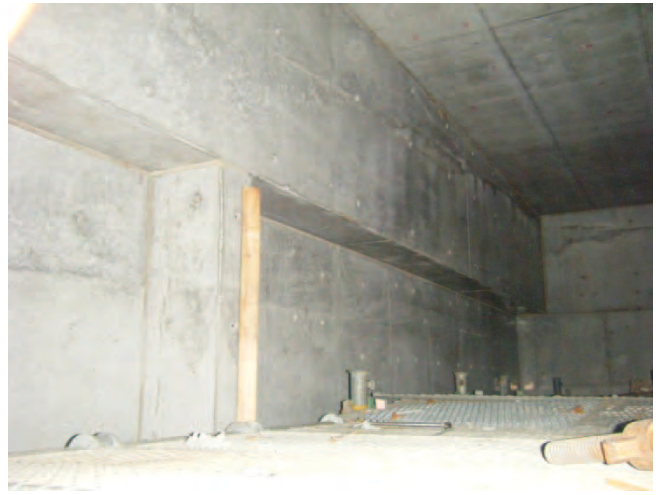
写真4. 地下1階外周壁（国産材型枠 脱型後のコンクリート表面）
