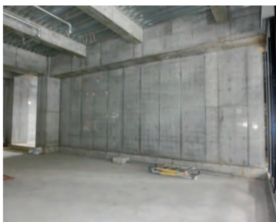
写真4．コンクリート壁面（国産材型枠）たわみ・はらみの問題なし
