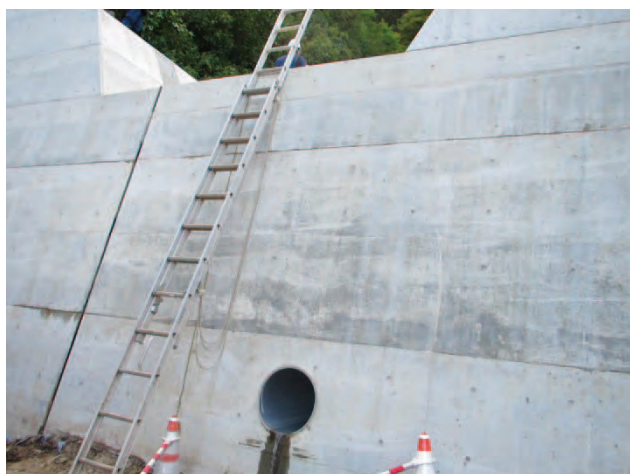
写真 6 . 完成した谷止工
