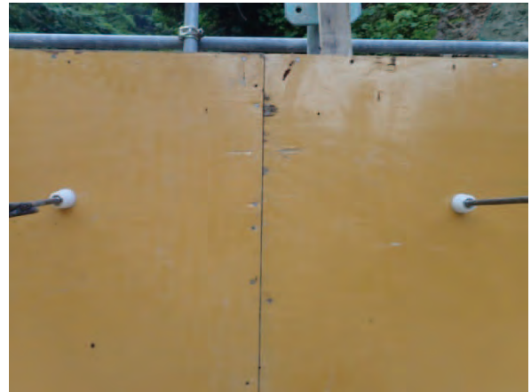
写真 9. 型枠継目の状況（転用 2 回目） 型枠の目違いもなく施工性は良
