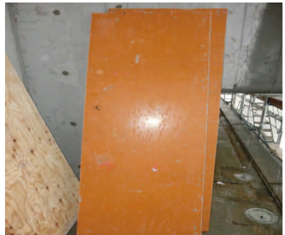
写真9．12回転用した国産材型枠の表（間仕切り壁用）
