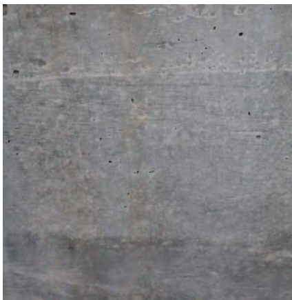
写真 10. 国産材型枠（U） 2 回目状況
