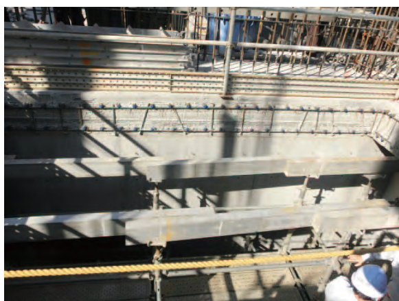
写真3．地下2階の梁部分
