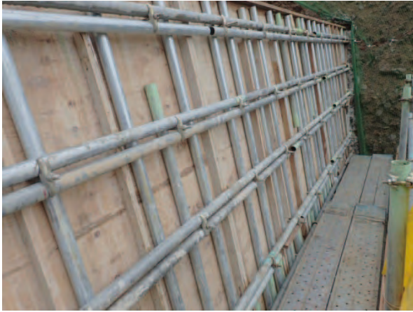
写真2．型枠設置の状況（転用2回目） 単管パイプの配置も南洋材と変わらない
