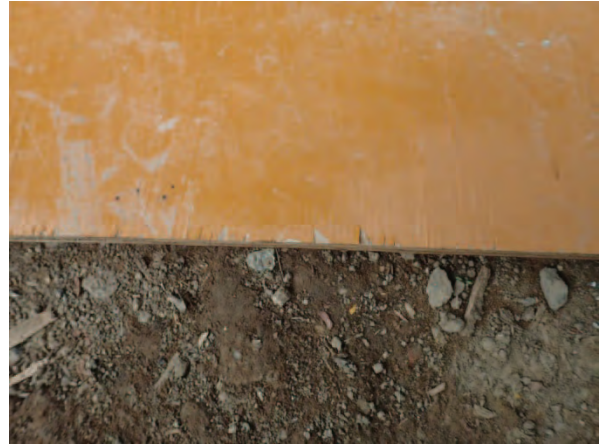
写真3．塗装面の状況（転用1回目） 塗装面の損傷もあまりみられない
