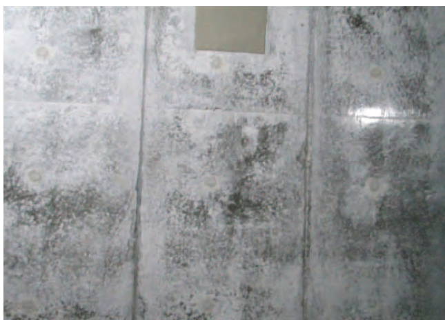
写真5. 地下1階の内壁建て込み：圧入式コンクリート打設工法（国産材型枠 2 × 6 サイズの縦使い、単管 3 本）
