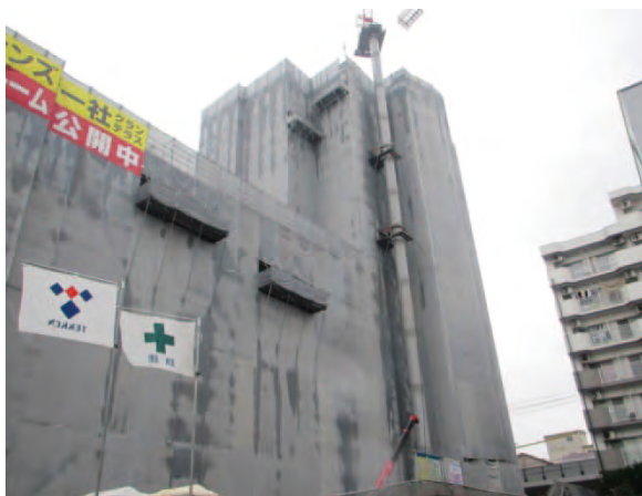
写真2．全景（15階で脱型中）
