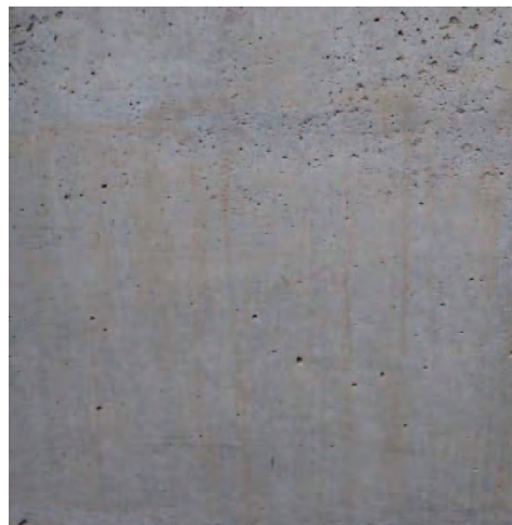
写真 12. ラワン型枠 1 回目状況
