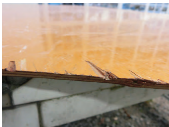
写真5. 切り使いした時の割れ (国産材型枠もラワン型枠も割れるが改善を要望)
