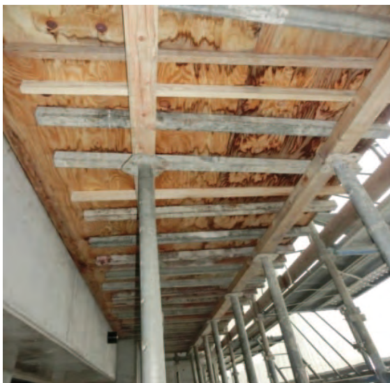
写真4．ベランダ、スラブの打設中 国産材型枠2種類を幅はぎにして使用
