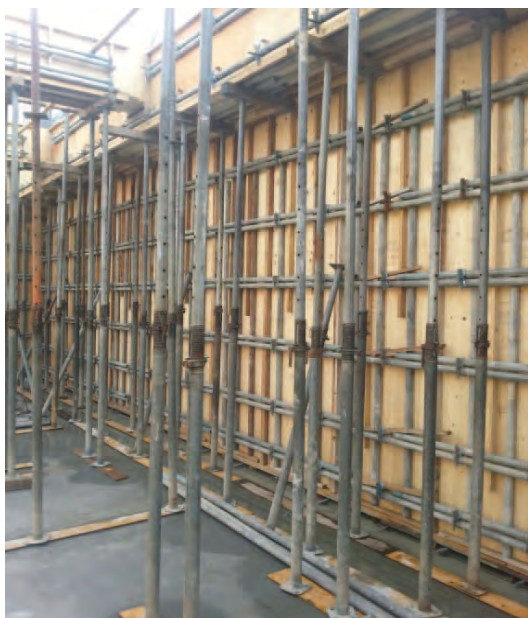
写真2．壁建て込み（国産材型枠 3×6サイズの縦使い）
