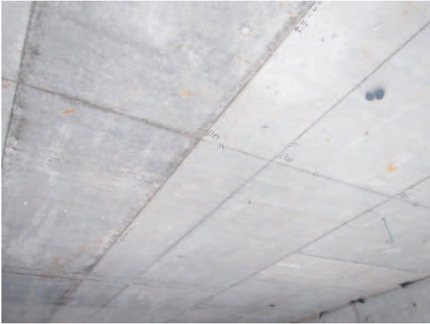
写真5. ラワン型枠使用のコンクリート表面
