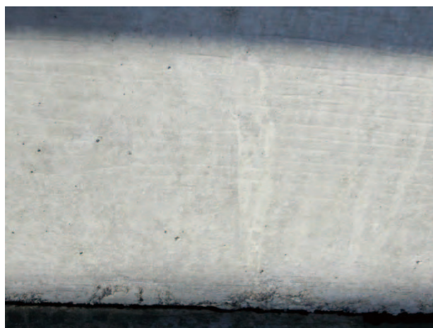
写真5．梁のシワ：構造上は全く問題なし（国産材型枠）
