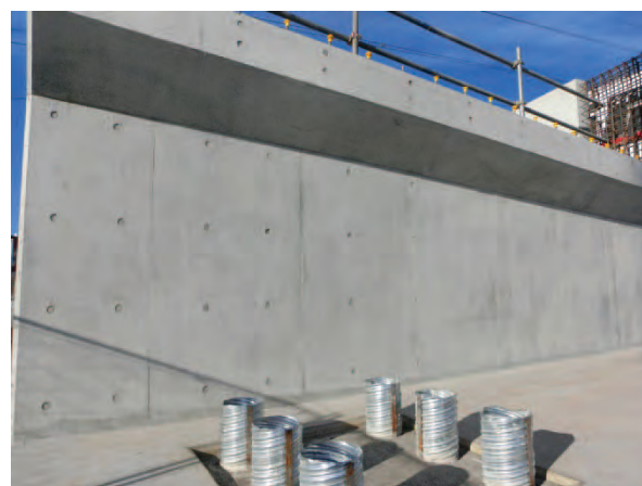
写真3. 完成時（国産材型枠）コンクリート表面
