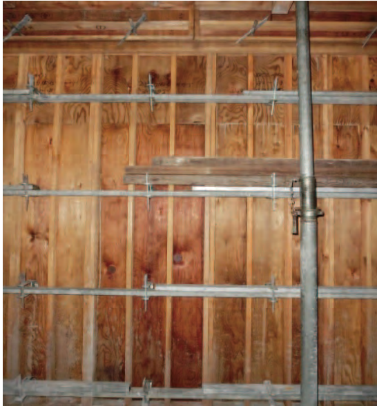
写真6．建て込み（5階）（国産材型枠 2 × 6 サイズの縦使い）
