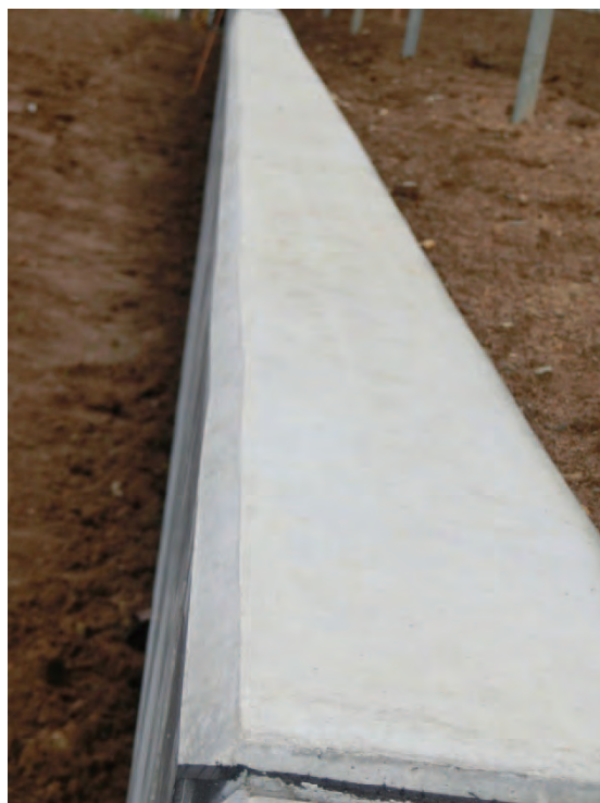
写真2．少し波打っている（国産材型枠）
