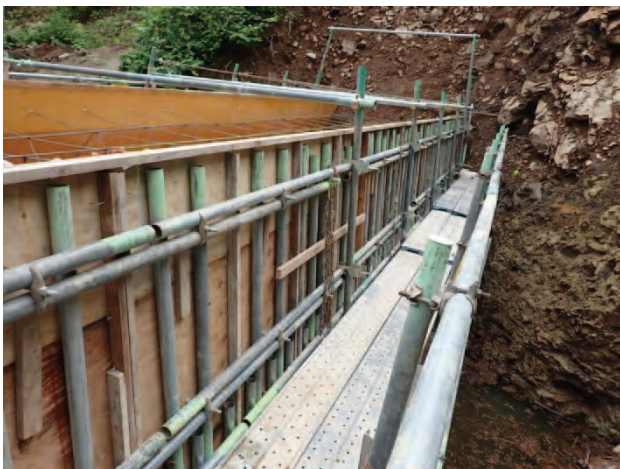
写真6．型枠設置の状況（転用2回目） 単管パイプの配置も南洋材と変わらない
