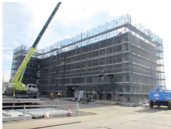
写真2. 宿舎棟の全景
