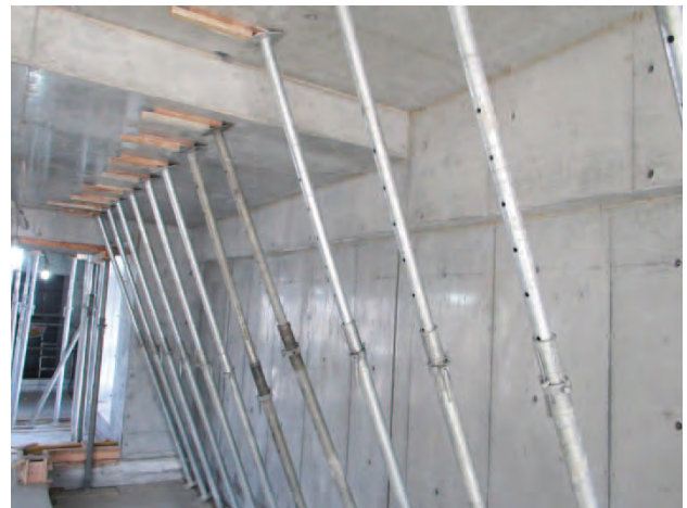
写真8. ラワン型枠による打設面（3階調査）
