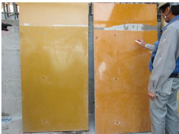
脱枠後の型枠面、灰色部分は付着したノロ
