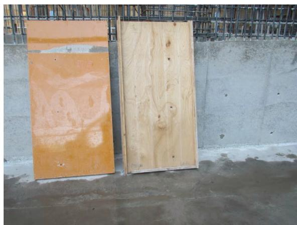
脱枠後の型枠面（国産材合板）
