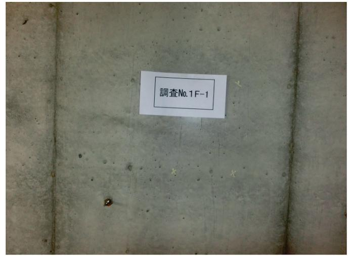
1階コンクリート壁面（No.1）（ラワン型枠）
