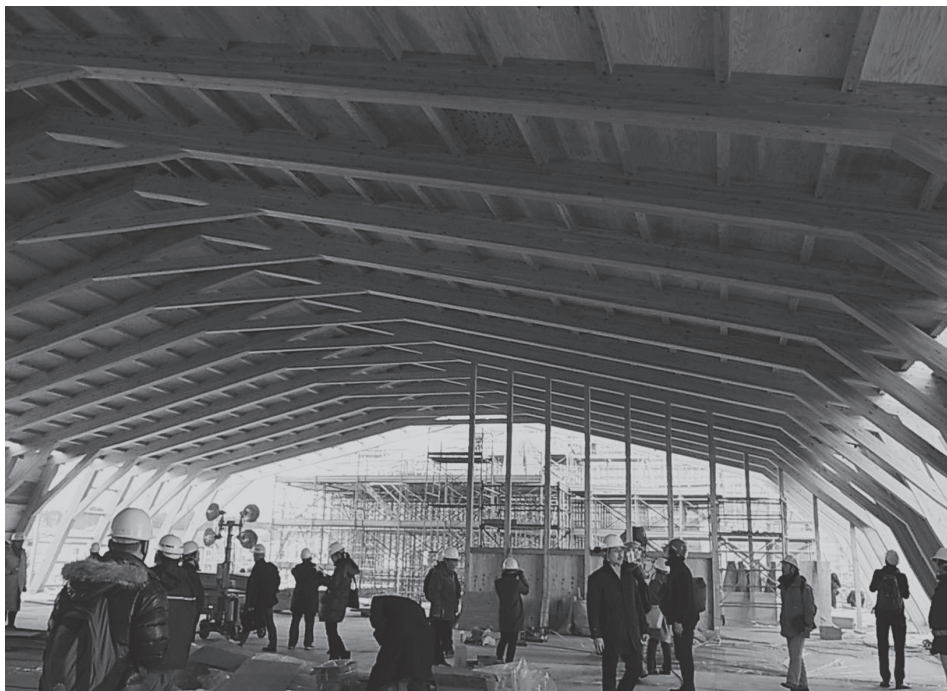
24mm構造用合板を用いた屋根構面
