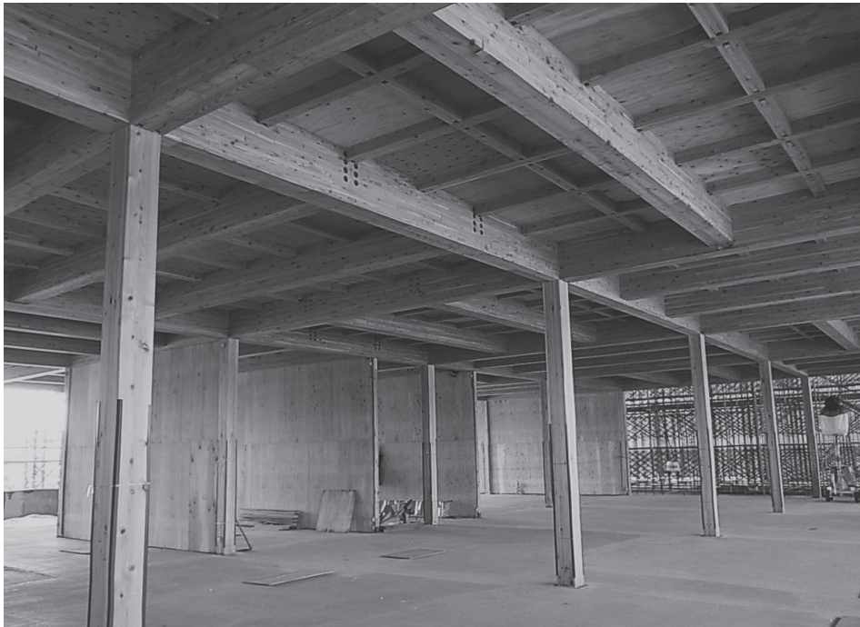
24mm 構造用合板を用いた耐力壁と床構面
