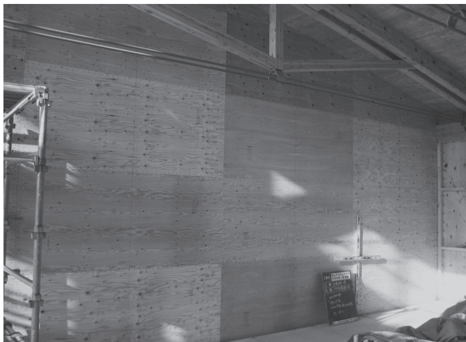
12mm構造用合板を用いた耐力壁
