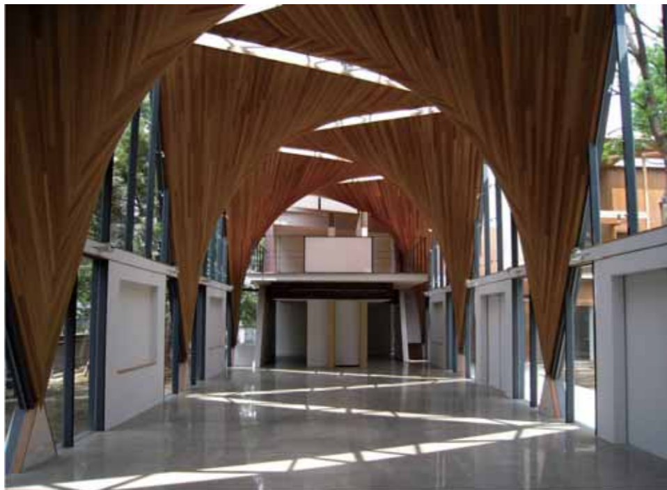
東京大学弥生講堂アネックス セイホクギャラリー：構造用合板によるシェル構造（河野泰治アトリエ 提供）
