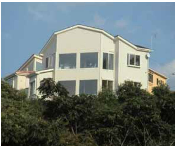
富津の家：1階床・2階床・小屋梁面をネダノンで、外壁をネダノンスタッドレス5 + で構成した壁量充足率4倍の高耐震住宅
