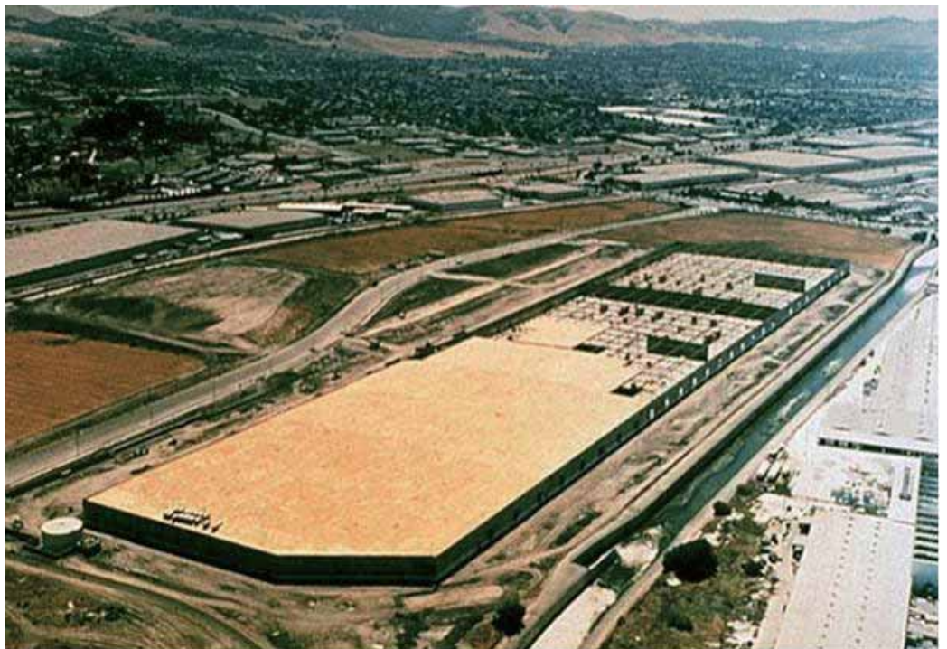
巨大倉庫：RC耐力壁と合板ダイアフラムで構成されている(アメリカ WWPA 提供)
