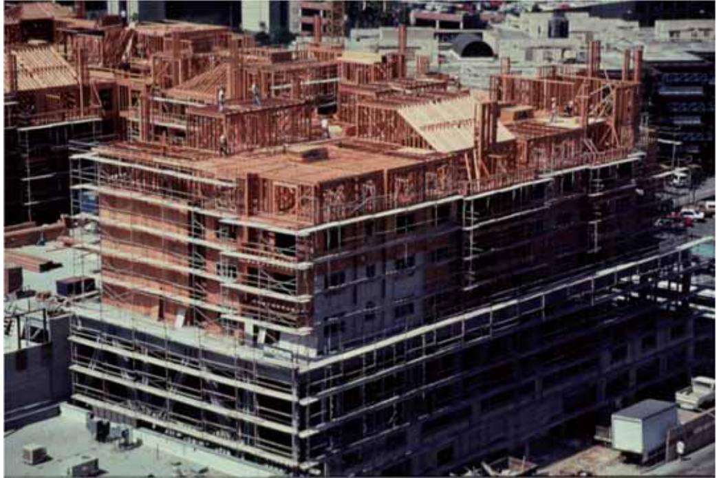
パインスクエア/パシフィックコート(カリフォルニア・ロングビーチ)：1～4階を鉄骨造、5～8階(+ペントハウス2階)を合板の壁・床・屋根による木造とした(アメリカ WWPA 提供)
