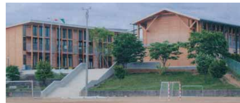
岐阜県高山市立中山中学校の木造校舎：床・壁・屋根下地に構造用合板を使用（株井上工務店 提供）
