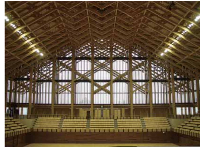
愛媛武道館：15mm構造用合板で構成した屋根構面（播設計室提供）
